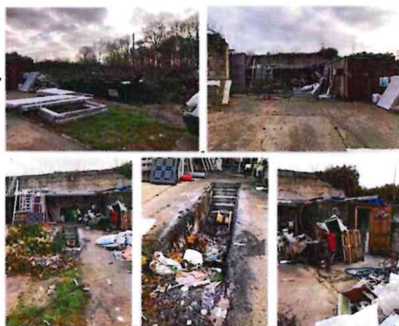
Figure 5: Photographies des zones de décharge de matériaux sur l'emprise du projet
